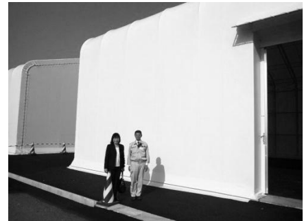
下水道処理場にできた焼却灰保管建屋
