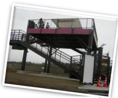
津波避難タワー
