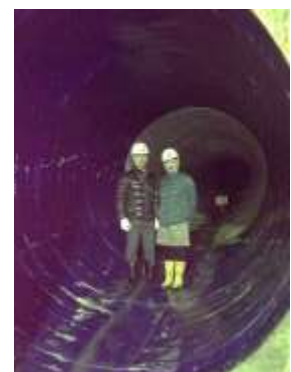
下水道トンネルの中で
