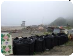
未だ進まない防ちよう堤工事
